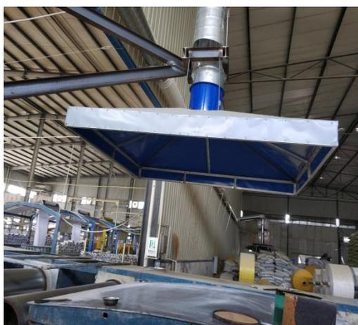
图 3.1 拉丝机上方集气罩
