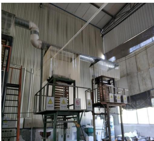
图 3.3 吹膜机上方集气罩
