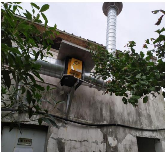
图 3.12 油烟净化器及排气筒
