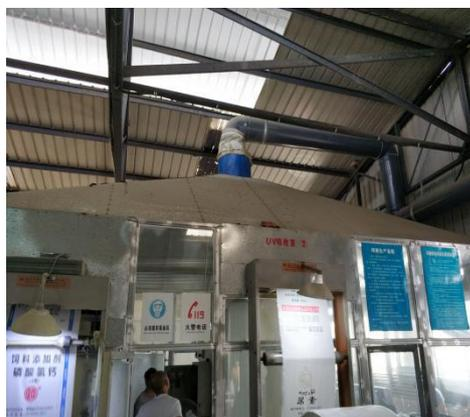
图 3.6 印刷机（彩印）单独隔间+负压抽风
