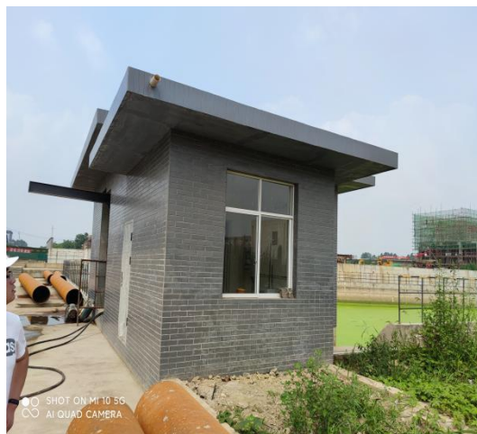
地埋式污水处理站
