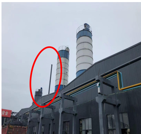
项目墙板、砌块生产线布袋除尘装置及排气筒（DA005）
