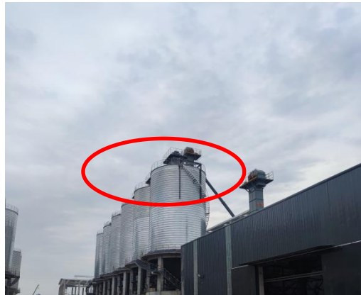
仓顶除尘器排气筒（DA004）
