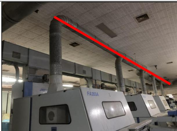
图 3-1 废气收集管道
