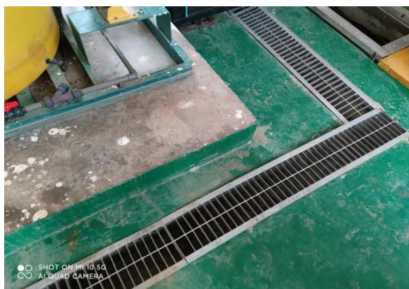
图 3-7 综合用房（一般固废暂存间）
