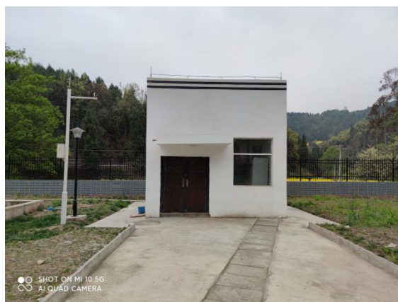
图 3-7 综合用房（一般固废暂存区）
