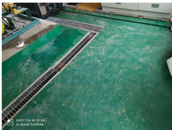
图 3-7 综合用房（一般固废暂存间）
