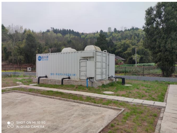
图 3-3 全封闭的一体化污水处理设备
