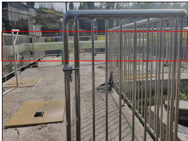
图 3-2 废气收集管道
