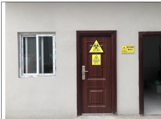
图 3.6 医疗废物暂存间
