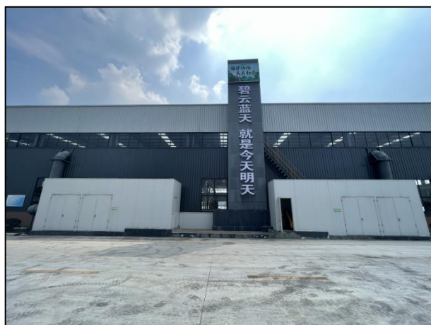
图3-1 1号厂房活性炭吸附装置及15m高排气筒 (DA001)
