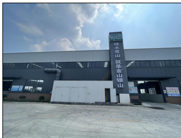
图 3-2 2 号厂房活性炭吸附装置及 15m 高排气筒 (DA002)
