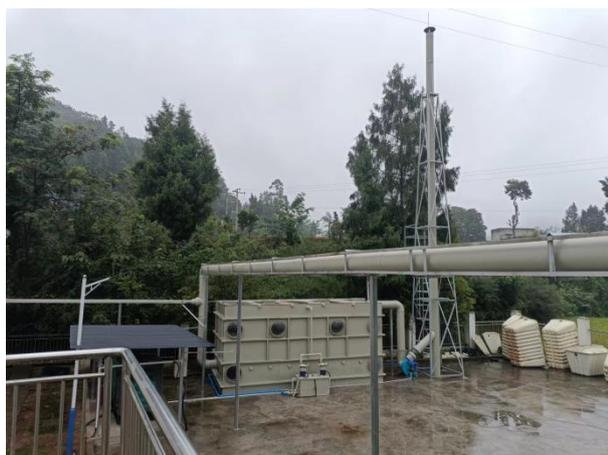
图 3-1 生物滤池除臭装置+15m 高排气筒
