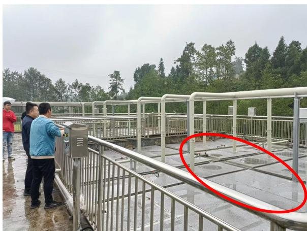
图 3-2 集气管道及玻璃盖板
