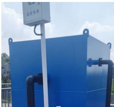
图 3-5 全封闭的一体化污水处理设备
