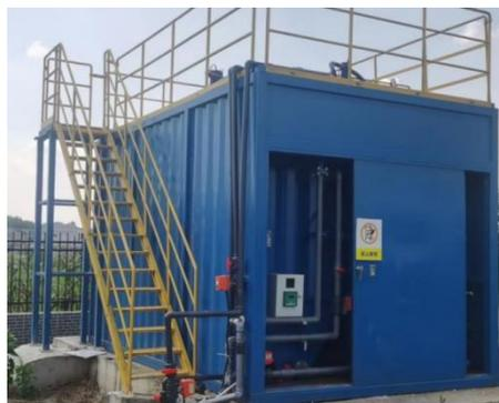
图 3-4 全封闭的一体化污水处理设备
