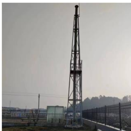
图 3-3 离子除臭装置
