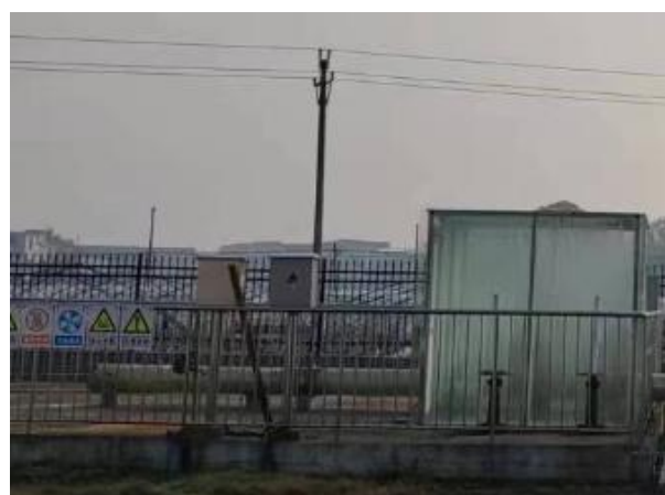
图 3-2 封闭式格栅间
