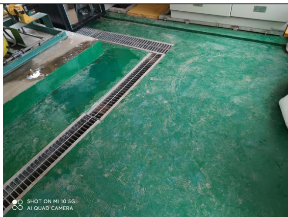
图 3-8 一般固废暂存间
