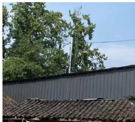
15m高排气筒（DA001）
